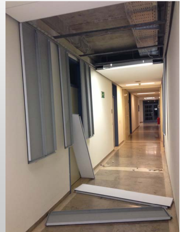
Foto 2013: abgehängte Decken heruntergefallen
